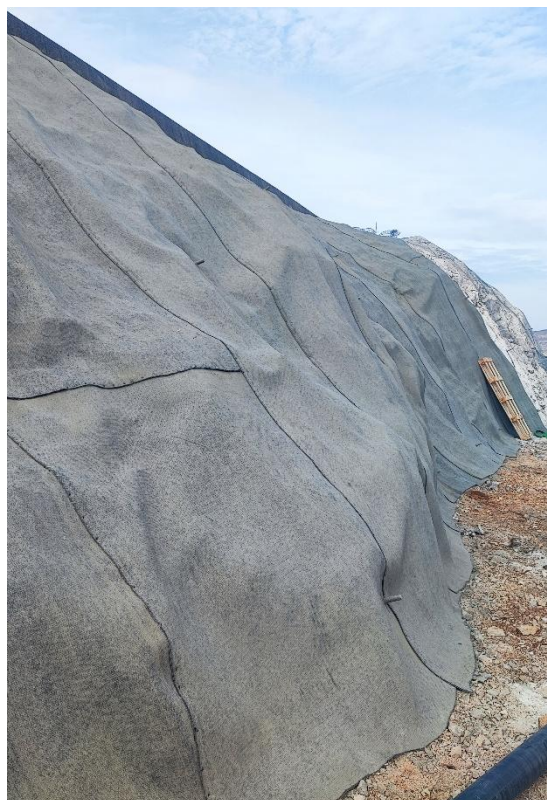
Slika 4. Prikaz spojeva geokompozita CCX-u na stijenskoj kosini
