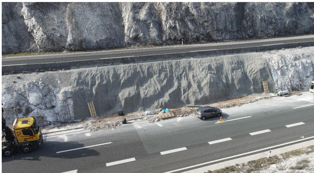
Slika 3. Ugrađeni geokompozit CCX-u na stijenskoj kosini na dionici autoceste
