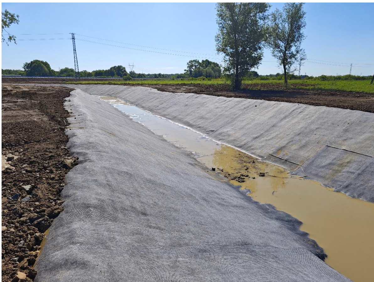
Slika 5. Ugrađeni geokompozit CCX-M kao obloga oborinskog kanala uz autocestu Zagreb-Sisak
