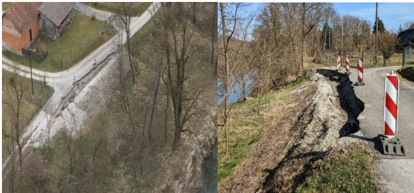
Slika 2 Prikaz klizišta C iz zraka (lijevo); konture klizne plohe na čelu klizišta (desno)
