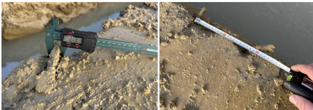
Slika 4. Mjerenje dimenzija armature (promjer i razmak šipki) potpornog zida
