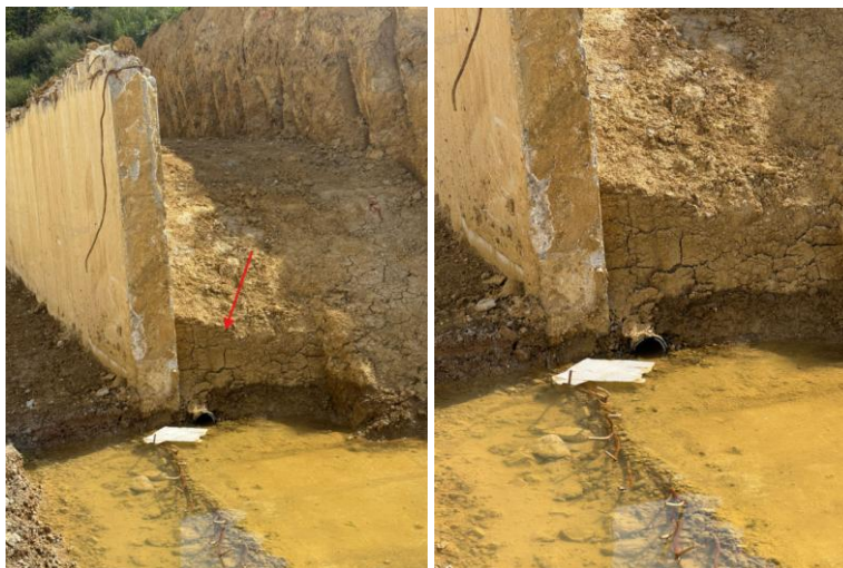
Slika 7. Izvedena drenaža iza potpornog zida
