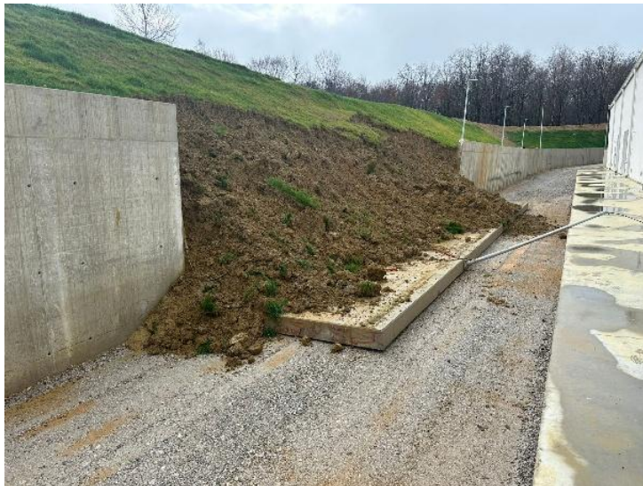
Slika 3. Situacija potpornog zida i nasipa iza zida neposredno nakon hazarda 1. dilatacije
