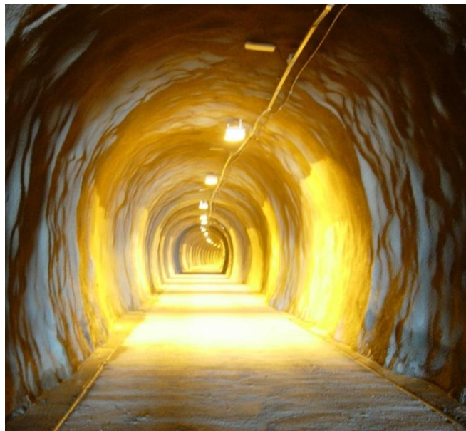
Slika 1. Prikaz servisne tunelske cijevi (servisnog tunela) Sv. Tri Kralja
