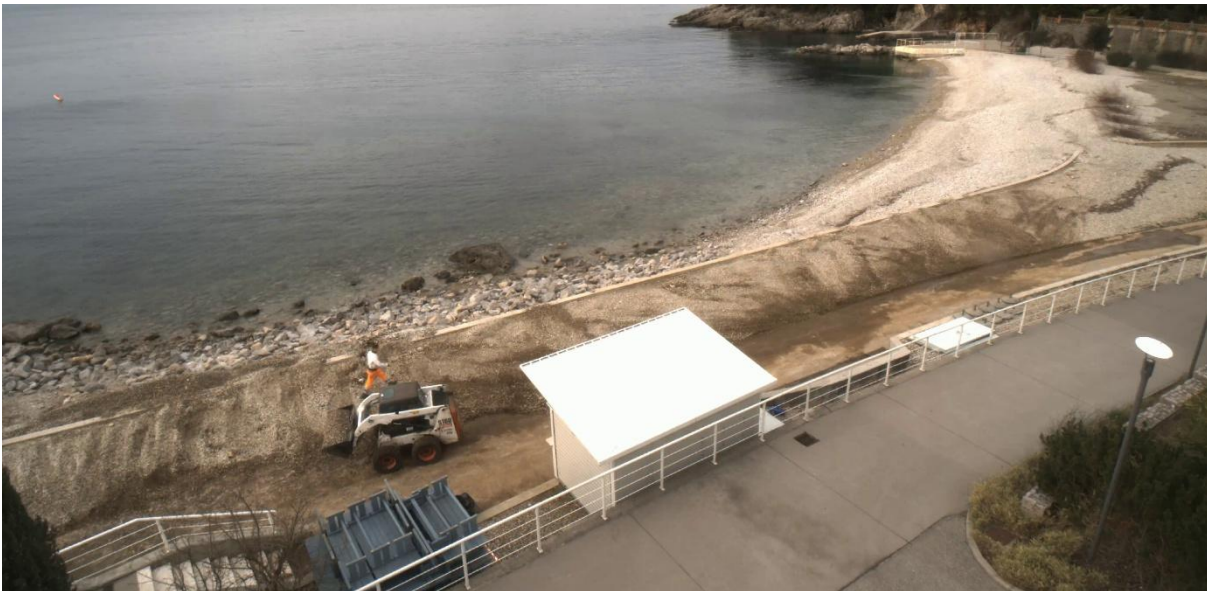
Slika 3. Građevinska intervencija na plaži Ploče (8.1.2021.)
