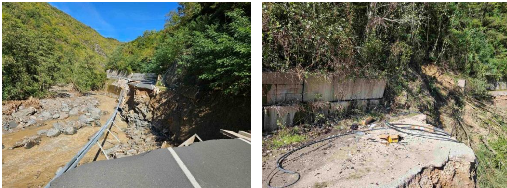
Slika 5. Oštećenja regionalnog puta R-437 uslijed bujične poplave rijeke Neretvice iz oktobra 2024.g.
