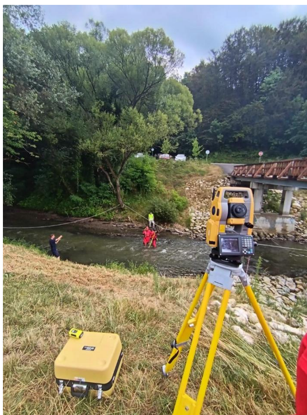
Slika 4. Mjerenje prostornih veličina totalnom stanicom
